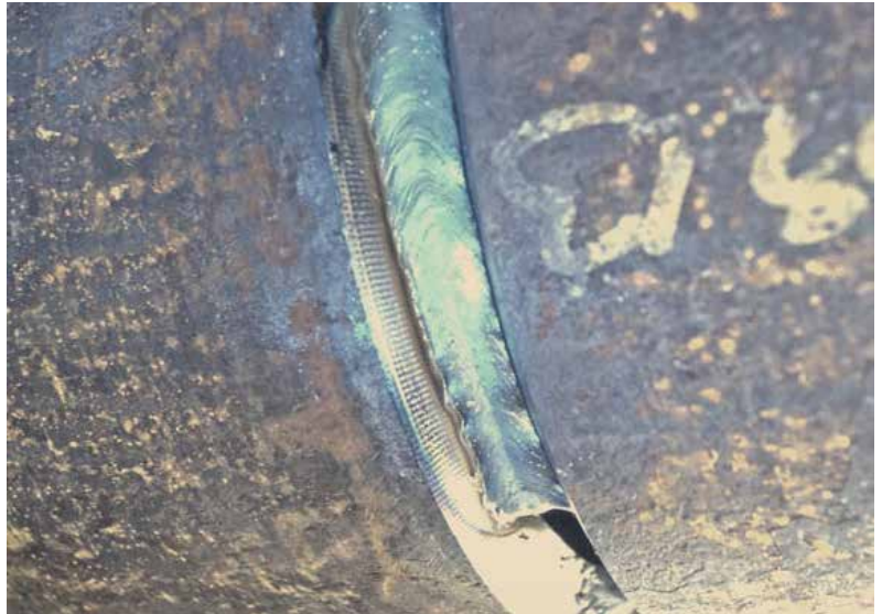
IAC™ - Soldadura vertical descendente de un cordón de raíz en una tubería de calefacción urbana. Aumento significativo de la velocidad de soldadura comparado con la soldadura tradicional ascendente.
