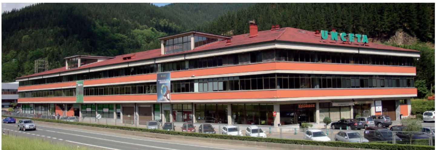
Nuestras instalaciones, Servicios centrales en Elgoibar
