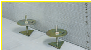
1º Posicionar niveladores.
