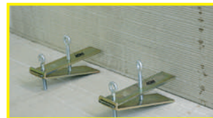
1º Posicionar niveladores.
