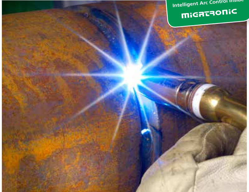
IAC™ - Soldadura vertical descendente de un cordón de raíz en una tubería de calefacción urbana. Aumento significativo de la velocidad de soldadura comparado con la soldadura tradicional ascendente.
